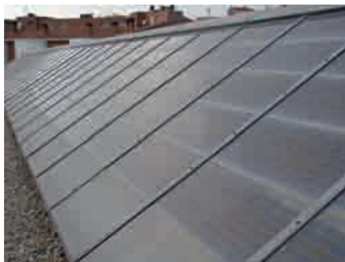
Lanterneaux sur le toit de la Bibliothèque de Mataró.
